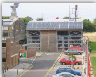
Chaudière collective à cogénération Quartier Vauban / Freiburg
