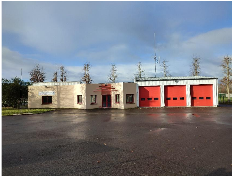
Le centre d'incendie et de secours
